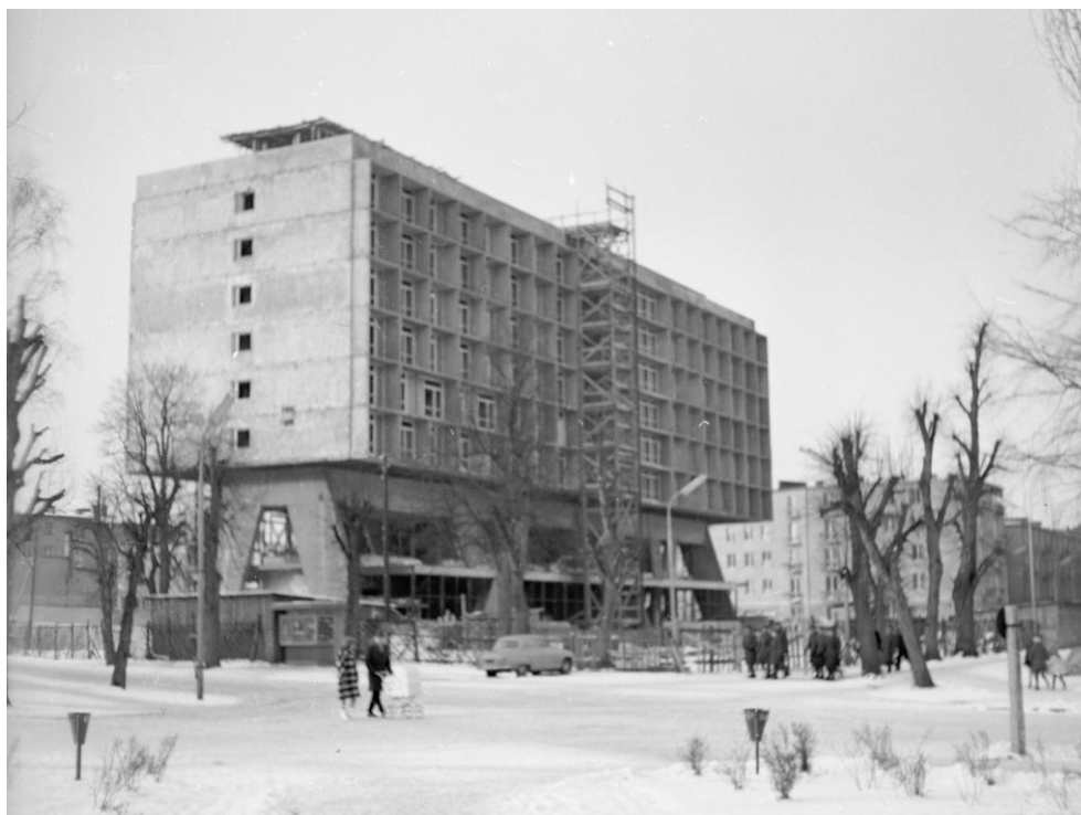
Rys. 2. Budowa hotelu Skanpol, 1964 r. [NAC]
