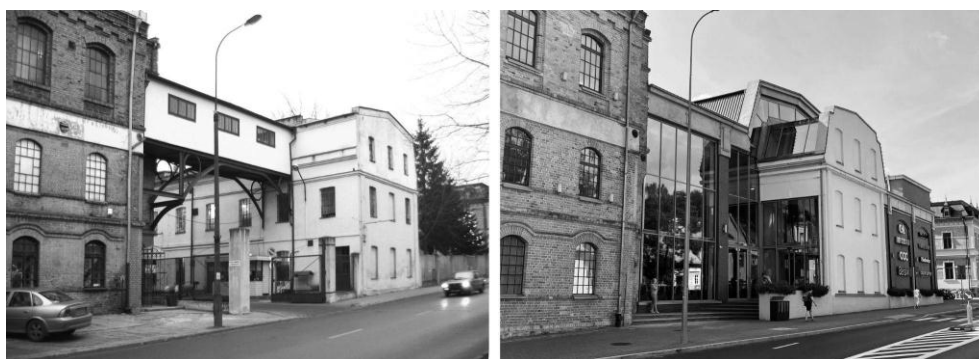
Rys. 8. Zestawienie pierzei ul. Świętojańskiej z roku 2006 [fot. Kuryłowicz 2023] i 2023 [fot. Karolina Misiuk]
