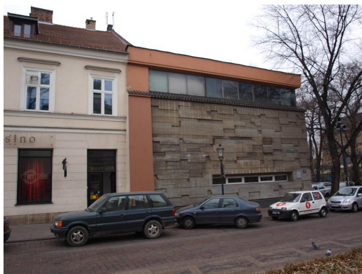
Rys. 9. Krystyna Różyska-Tołłoczko, Miejski Pawilon Wystawowy „Bunkier Sztuki” w Krakowie, 1959-1965 [fot. autor]
