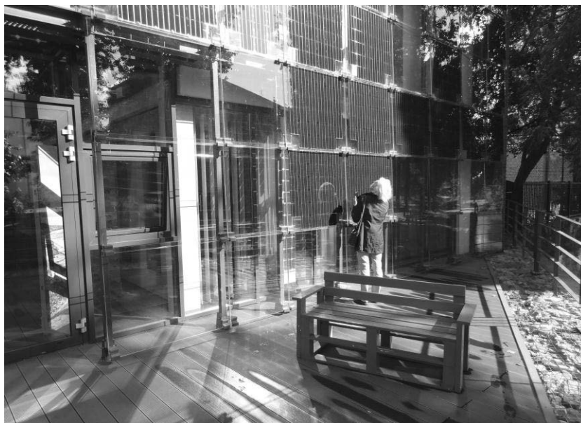
Rys. 6. Podwójna elewacja, płaszcz zewnętrzny stanowi stelaż pod panele fotowoltaiczne. Budynek WFOŚiGW, Gdańsk [fot. M. Trojanowska]
