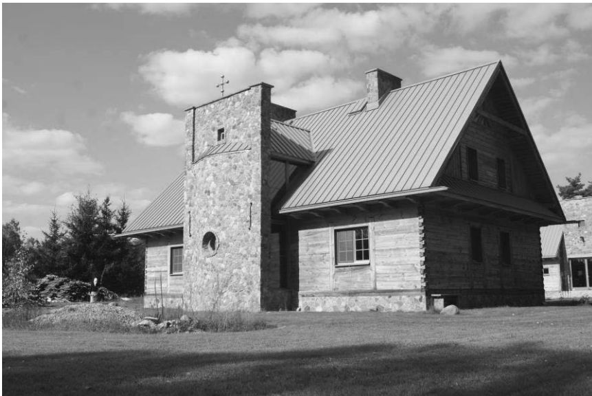
Rys. 25. Poletyły. Rzymskokatolicka pustelnia – kartuzja wiejska. Widok zewnętrzny domu-kaplicy Zwiastowania NMP od strony południowej. Autor architektury: Jerzy Uścińowicz, 2017 r. [zdj. J. Uścińowicz]
