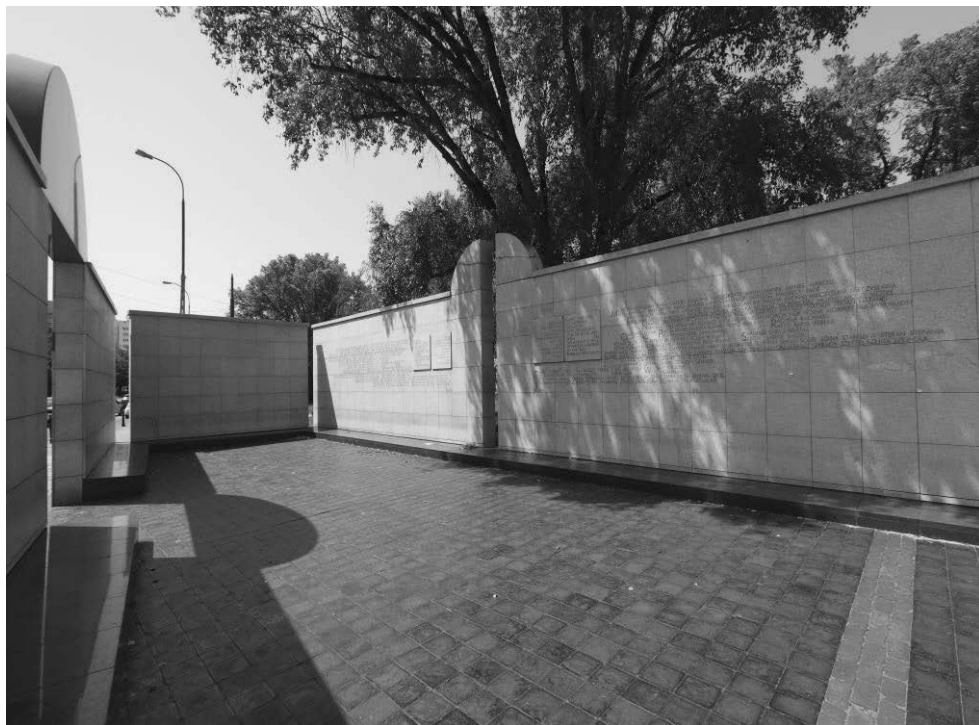
Rys. 13. Odświeżony w 1988 r. w Warszawie mur-pomnik Umschlagplatz z inskrypcją w czterech językach – polskim, jidysz, angielskim i hebrajskim: „Tą drogą cierpienia i śmierci w latach 1942-1943 z utworzonego w Warszawie getta przeszło do hitlerowskich obozów zagłady ponad 300 tys. Żydów” [zdj. K. Pleskaczyńska]
