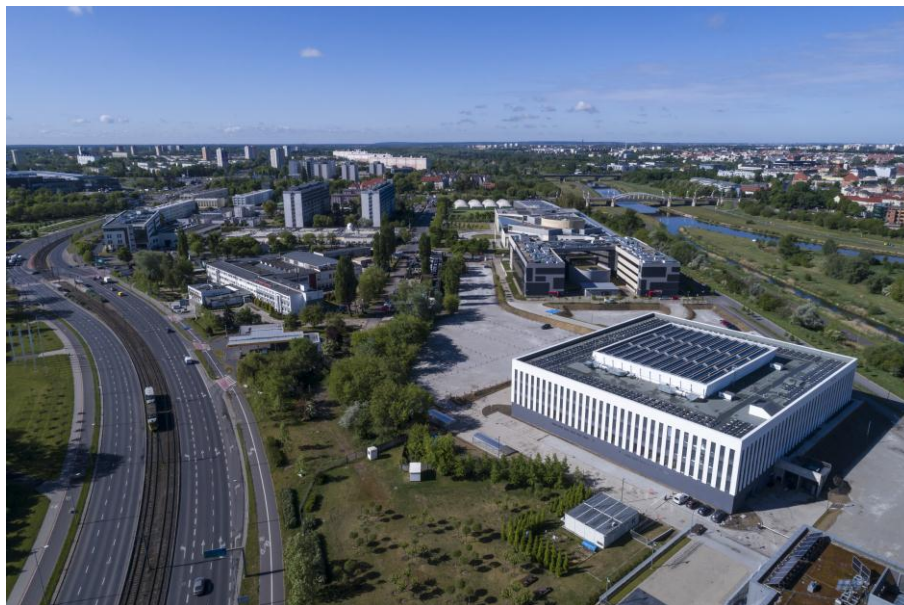
Rys. 11. Zdjęcie kampusu z lotu ptaka – widok na piątą elewację budynku WAWIZ [Zasoby Politechniki Poznańskiej, Dział Promocji]
