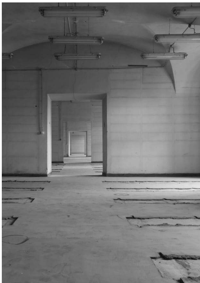
Rys. 7. Wnętrze byłej biblioteki Na Piasku, Wydział Judaistyki Uniwersytetu Wrocławskiego, Wrocław, 2022 [fot. K. Bogusz]
