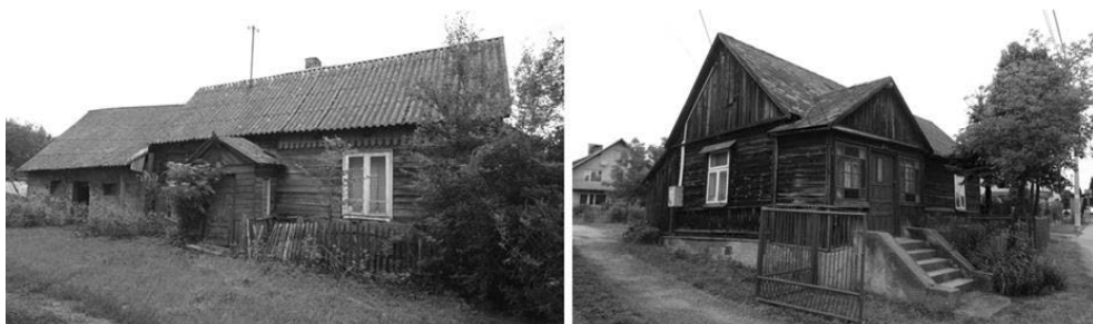
Rys. 3. Budownictwo drewniane: chałupa z Domaszowic, ul. Świętokrzyska (A); chałupa z Leszczyn (B) [fot. M. Purski, 2021]
