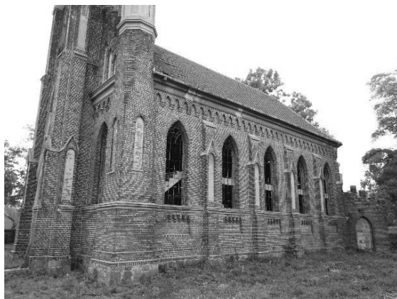
Rys. 4. Widok na boczną elewację [fot. Ł. Rosiak]
