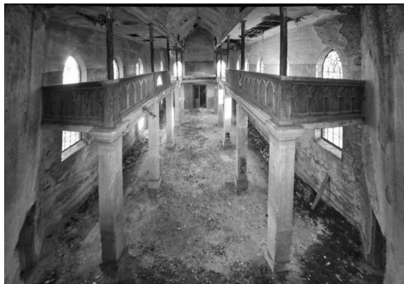
Rys. 5. Widok wnętrza kościoła wraz z widokiem na empy [fot. A. Kotkowski]
