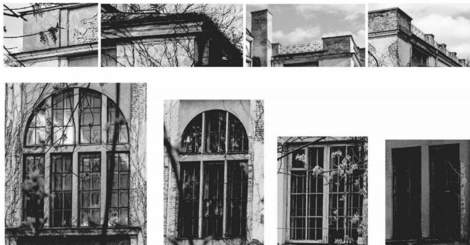
Rys. 9. Elektrownia Falenicka – detale okien i elewacji, kwiecień 2022 [fot. A. Czeranowski]
