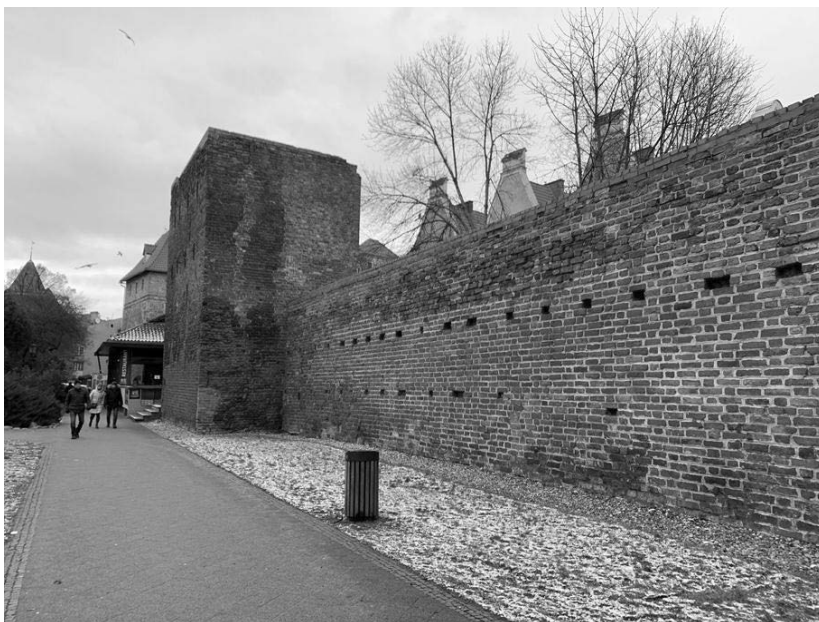
Rys. 7. Elewacja południowo-zachodnia z widokiem na Basztę i otwory maculcowe w murze [opracowanie własne]
