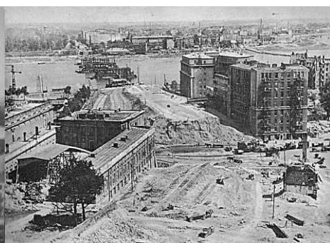
Rys. 4. Budowa Mostu Śląsko-Dąbrowskiego i trasy W-Z [Małcużyński 1955]
