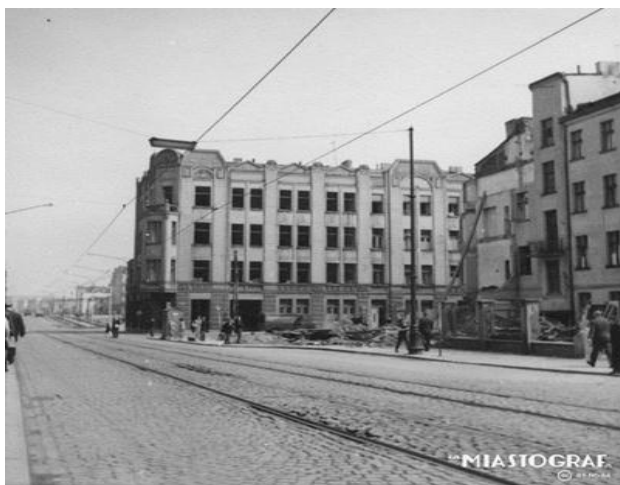
Rys. 2. Hotel Bristol w Łodzi róg ulic Zachodniej i Próchnika tuż przed częściową rozbiórką [Miastograf 2022]
