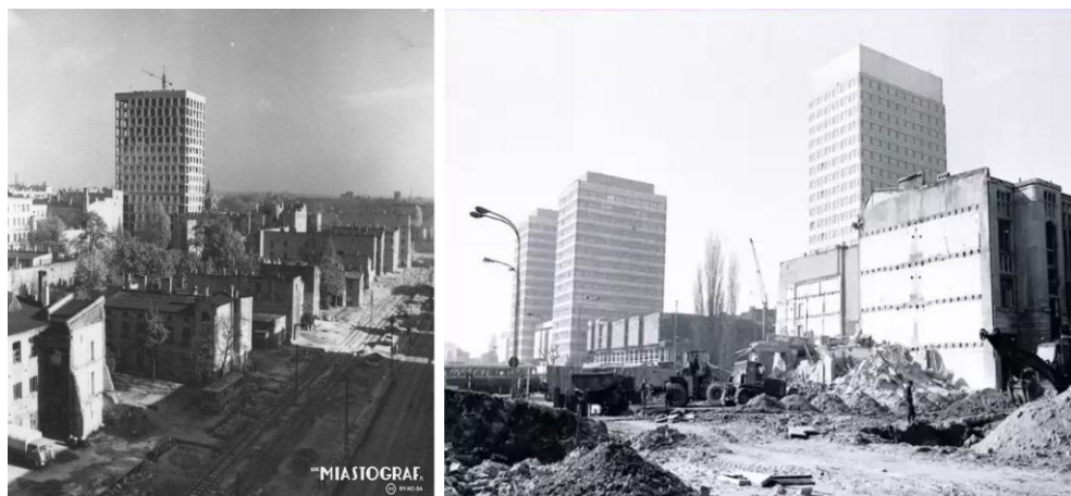
Rys. 18. Łódź – dwa etapy budowy Trasy WZ. Po lewej wyburzenia ulicy Główniej w latach sześćdziesiątych [Miastograf]. Po prawej – budowa arterii w latach siedemdziesiątych, na tle „gniazda” nowego centrum Łodzi [archiwum gazety „Express Ilustrowany”]
