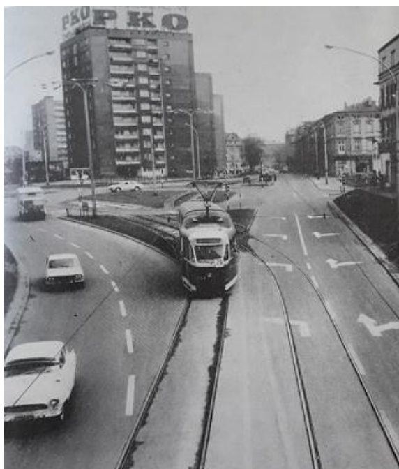
Rys. 5. Centrum Sosnowca w trakcie modernizacji [Kasprów, Knobelsdorf 1977]
